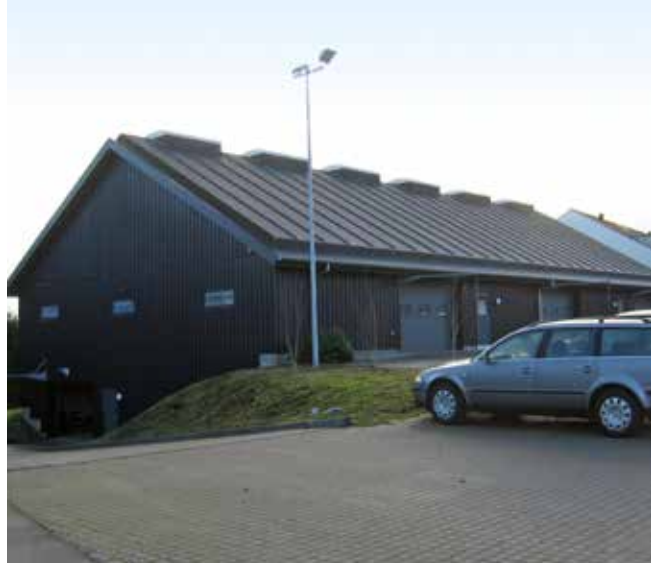
Kirkegårdskapellet er bygget i 1965, og er blevet moderniseret og tilbygget i 1988. Senest er der bygget ny maskinhal med værksted og fuld kælder på i alt 600 m 2 .
